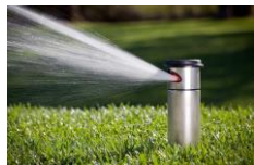
En av Östorps vattenspridare, Hunter I25
